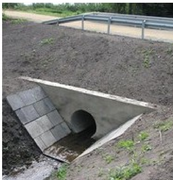
Fot. 5. Przykłady umocnienia skarp i dna rowu w sąsiedztwie wylotu przepustu
