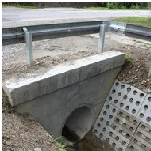
Fot. 5. Przykłady umocnienia skarp i dna rowu w sąsiedztwie wylotu przepustu
